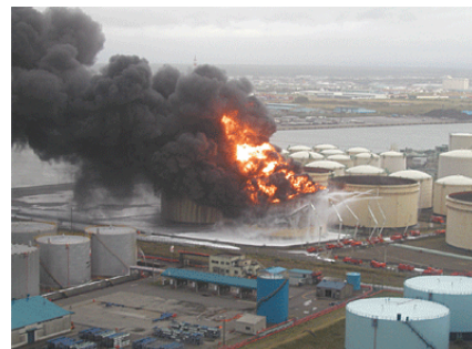
写真-2 2003年十勝沖地震における浮屋根の沈没とタンク全面火災
